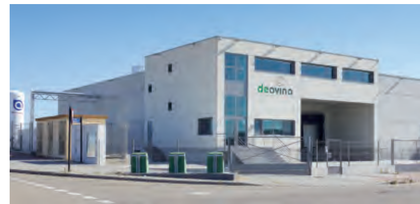
Instalaciones de Deovino, la primera empresa comercializadora que ha obtenido el certificado BAIE.
