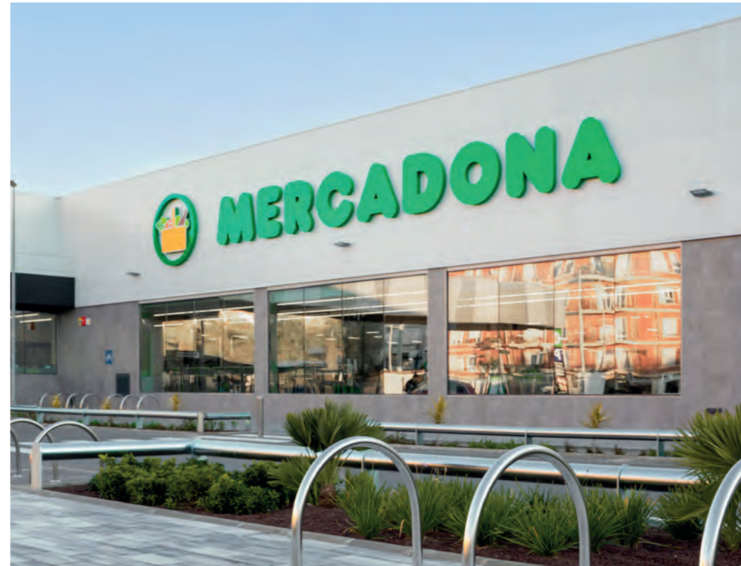
Fachada del supermercado de Xirivella (Valencia), que es la primera tienda con este modelo.
